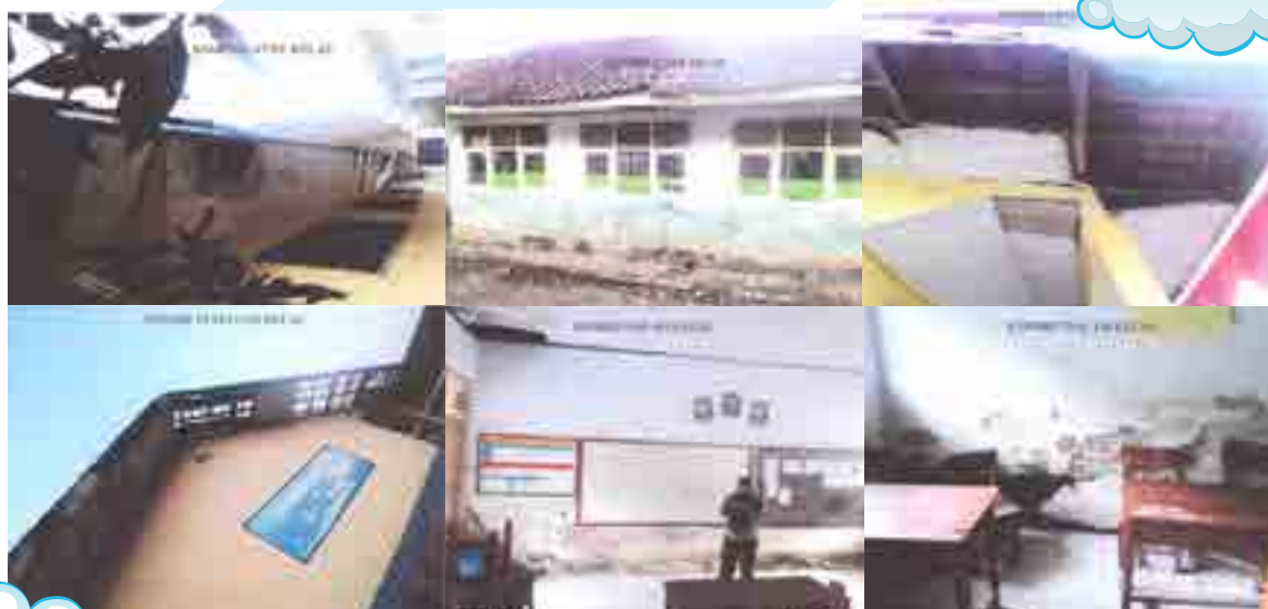
Foto sekolah SD Negeri 1 Cibuh sebelum direnovasi Picture of SD Negeri 1 Cibuh before renovation
